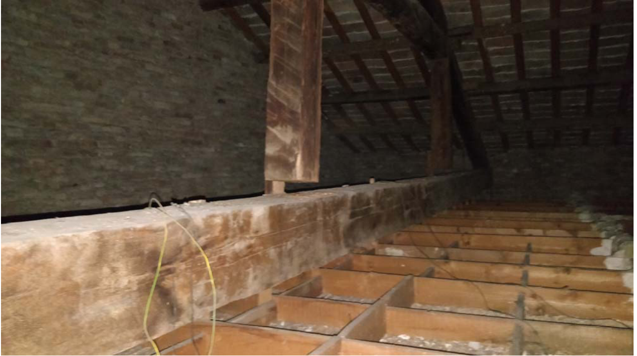
Vista delle capriate lignee esistenti nella copertura del blocco denominato "Ex scuola di musica"
