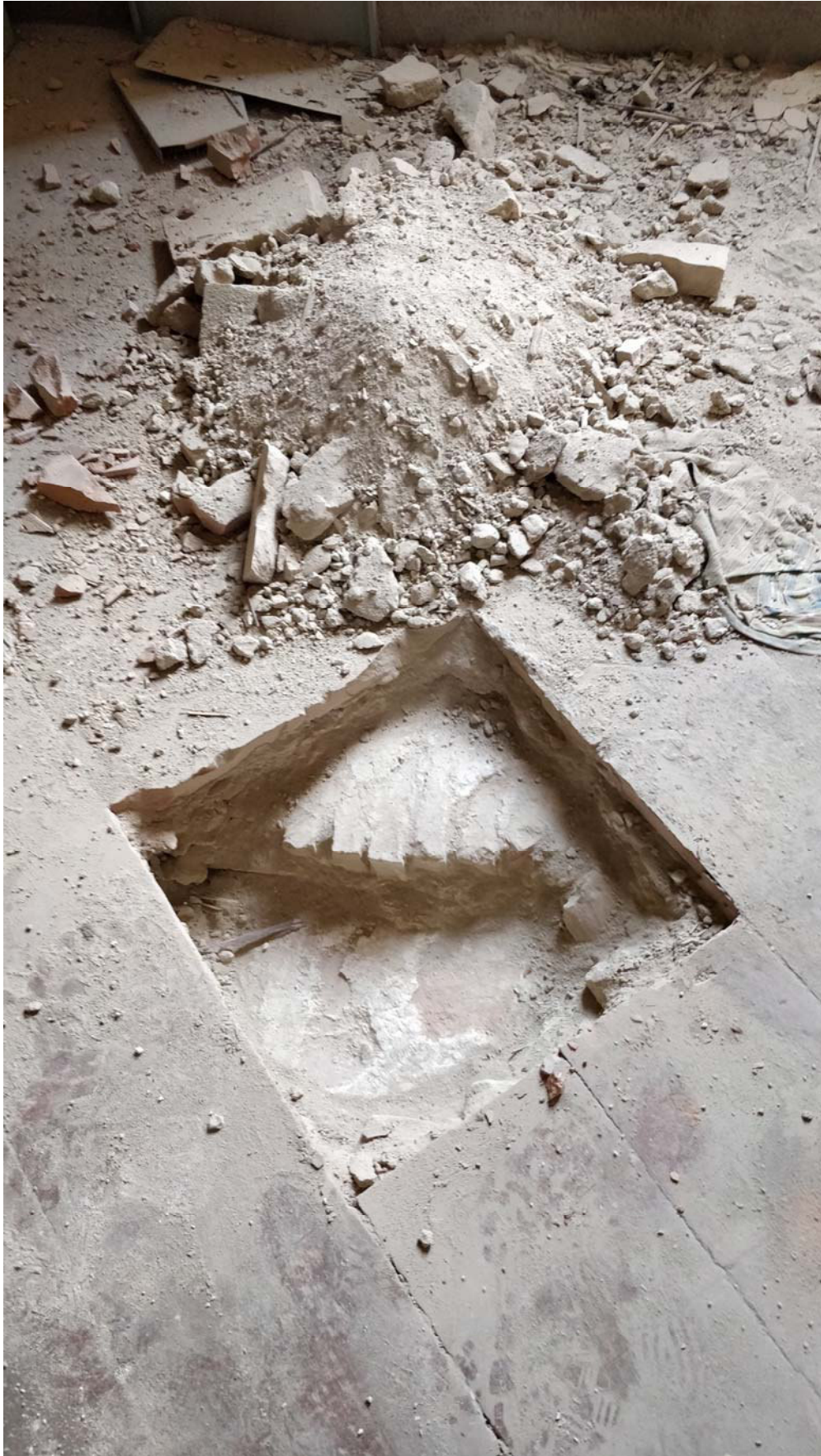
Sondaggio su uno degli orizzontamenti del piano secondo del blocco denominato Ex scuola di musica che evidenzia la presenza di una volta con frenelli in muratura di mattoni pieni (sondaggio S1)
