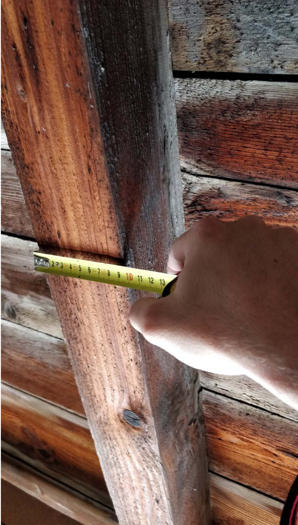
Misurazione della larghezza dei travetti (10 cm)
