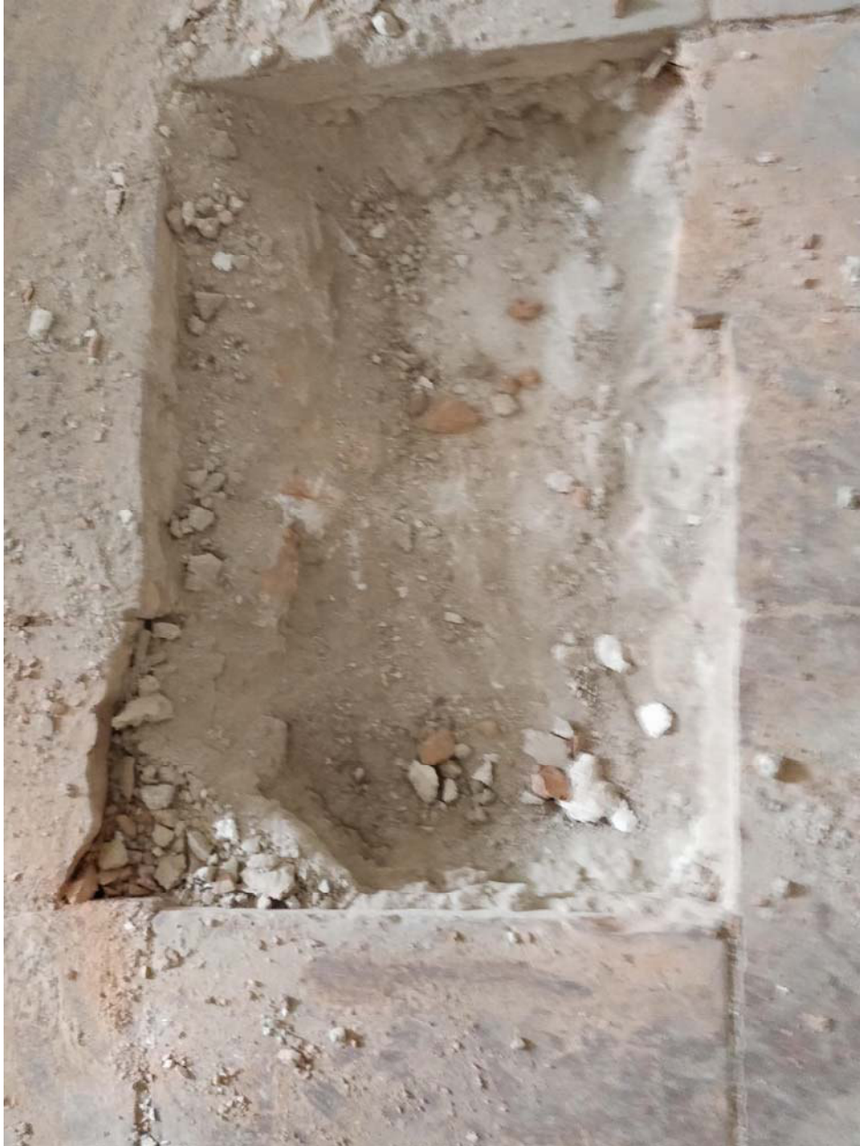
Sondaggio su uno degli orizzontamenti del piano secondo del blocco denominato Ex scuola di musica che evidenzia la presenza di una volta in muratura (sondaggio S3)
