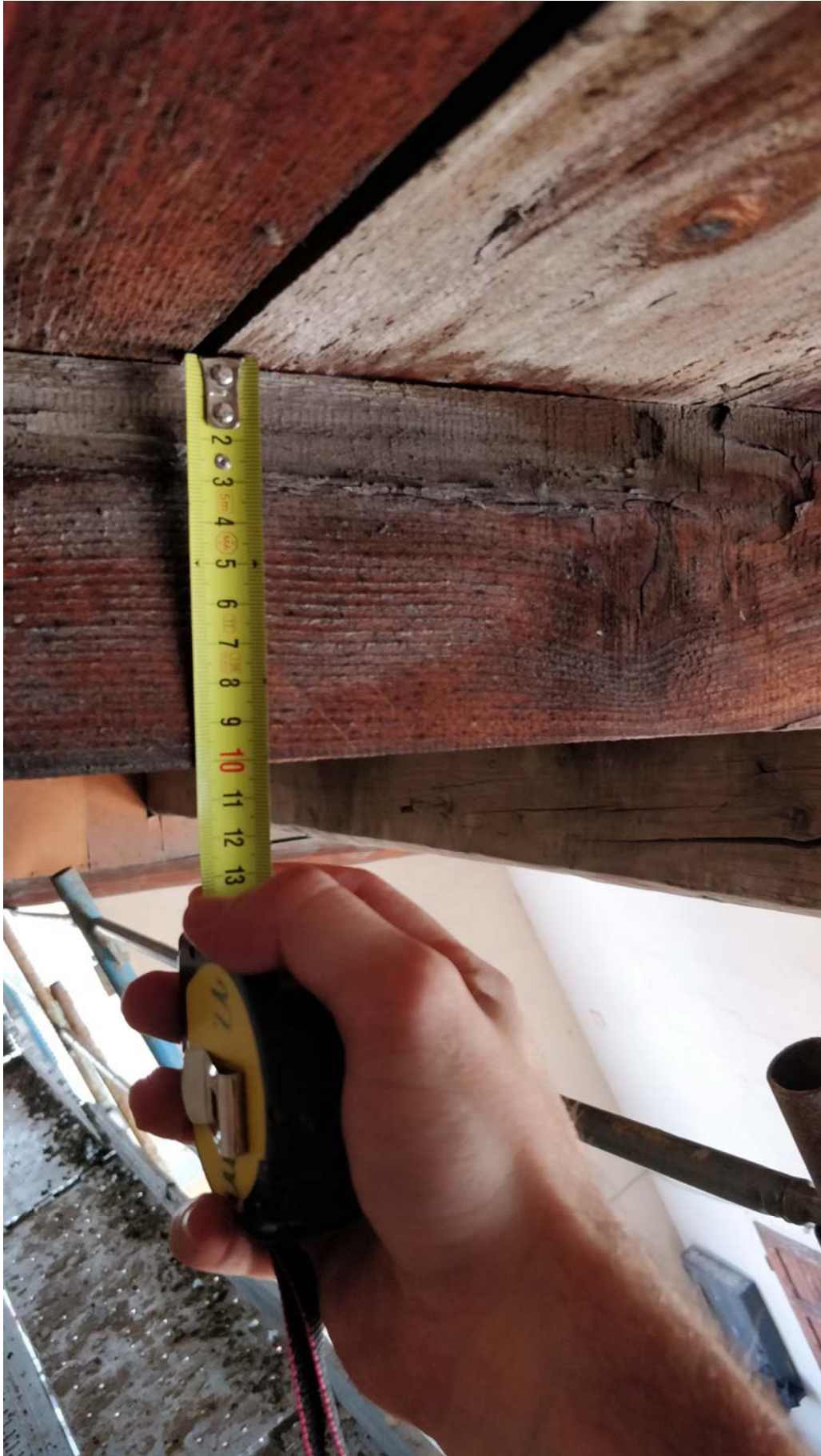
Misurazione dell'altezza dei travetti (10 cm)
