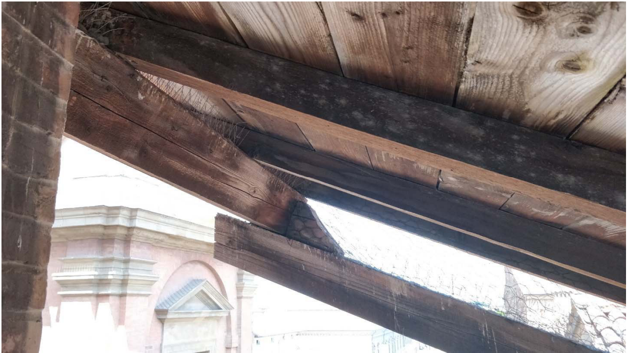
Copertura della loggia sul lato che affaccia e sbalza verso la torre dell'orologio
