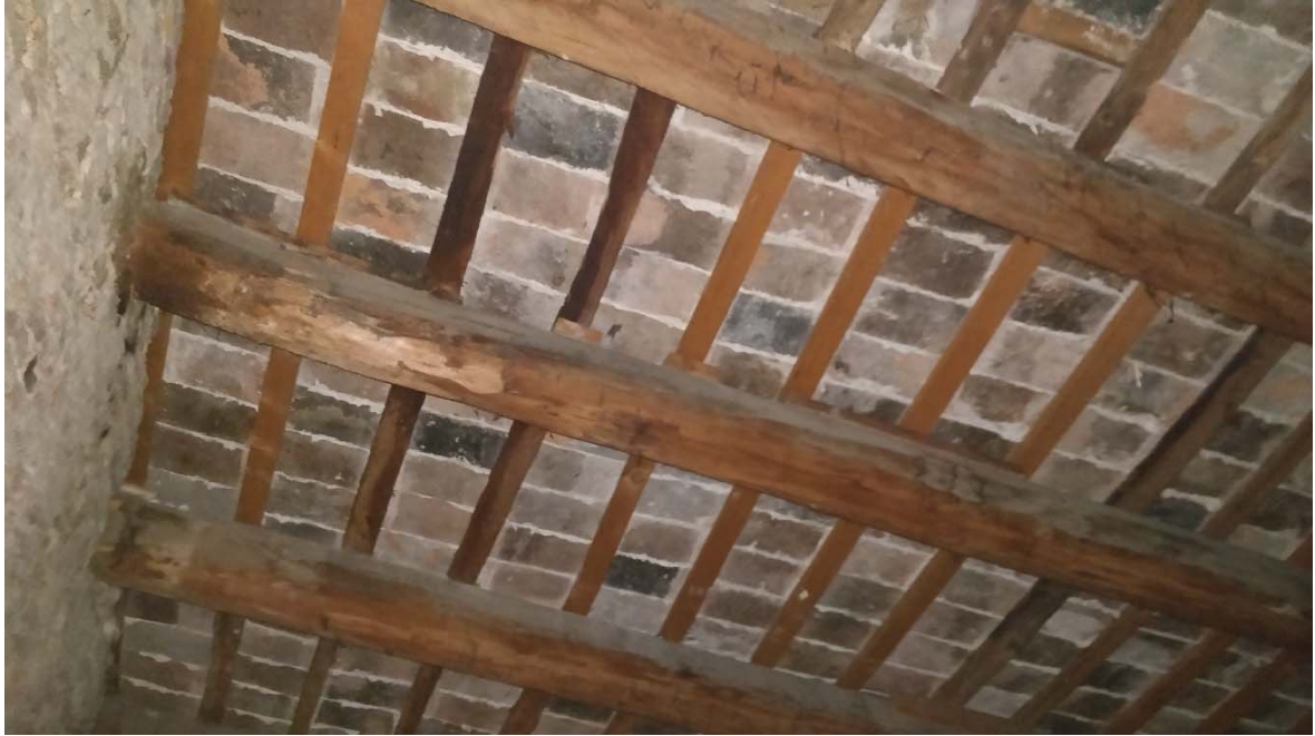
Vista delle orditura lignee esistenti nella copertura del blocco denominato "Ex scuola di musica"
