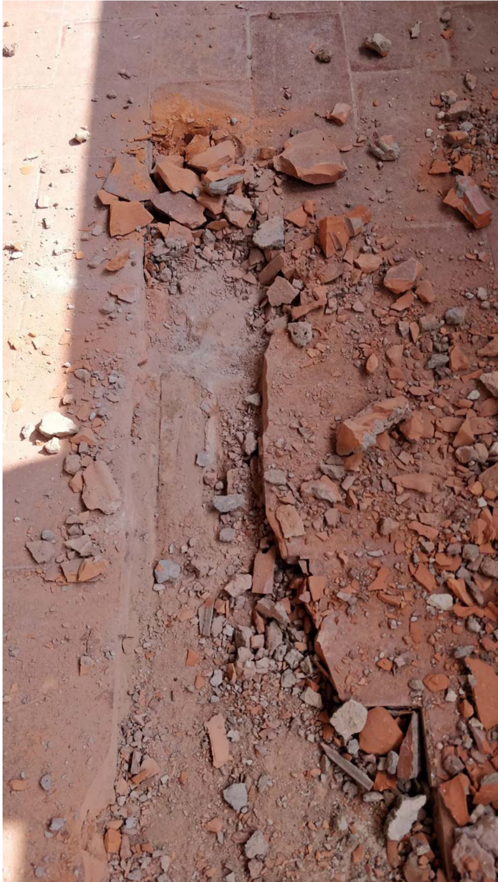
Sondaggio sul solaio di piano secondo interno alla loggia su Piazza dei Martiri che evidenzia la presenza di putrelle metalliche e tavelloni in laterizio (sondaggio S7)
