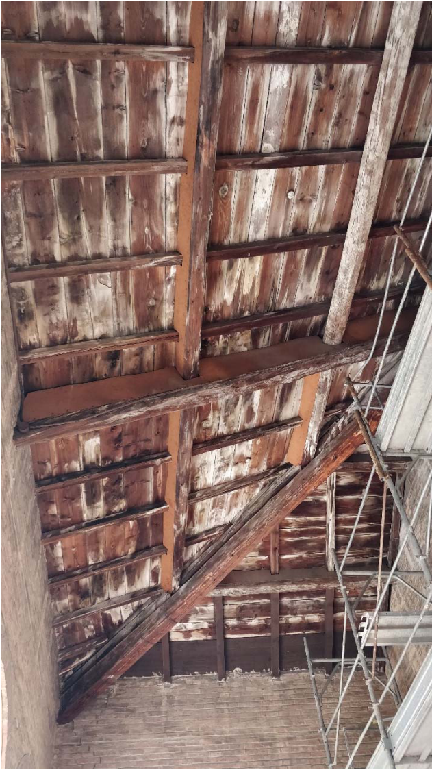
Attuale conformazione della copertura spingente
