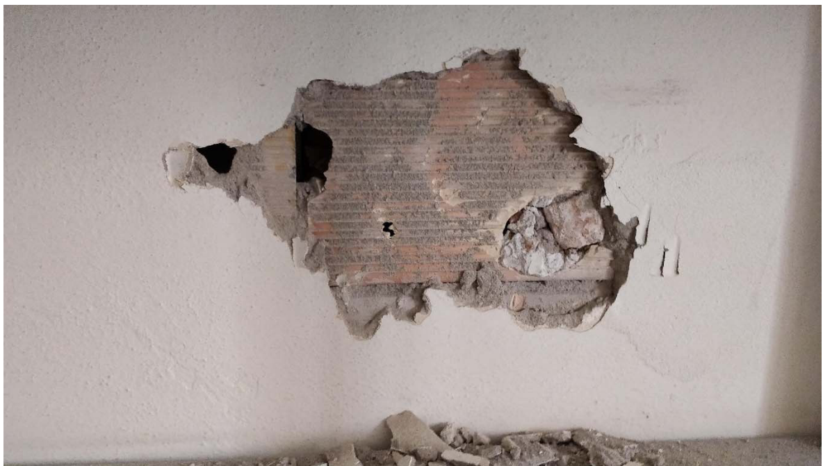
Sondaggio su una delle pareti interne ai locali del secondo piano (Ex scuola di musica) che evidenzia la tessitura muraria in mattoni forati disposti in foglio (sondaggio S10)
