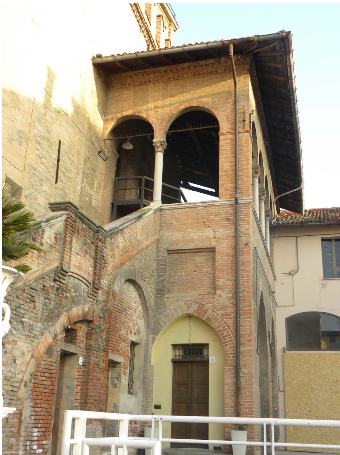
Il volume addossato dal lato di Piazza Martiri della Libertà con la scala di accesso
