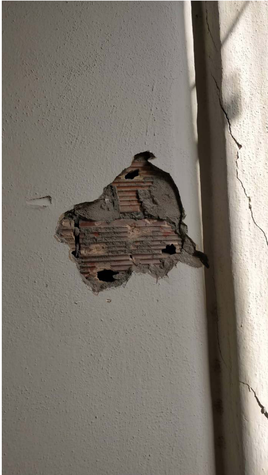
Sondaggio su una delle pareti interne ai locali del secondo piano (Ex scuola di musica) che evidenzia la tessitura muraria in mattoni forati disposti in foglio (sondaggio S9)
